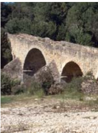
Pont de Buidasacs
